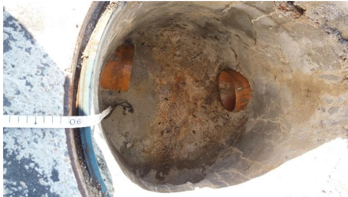
Toma de Datos de la Profundidad del pozo.
