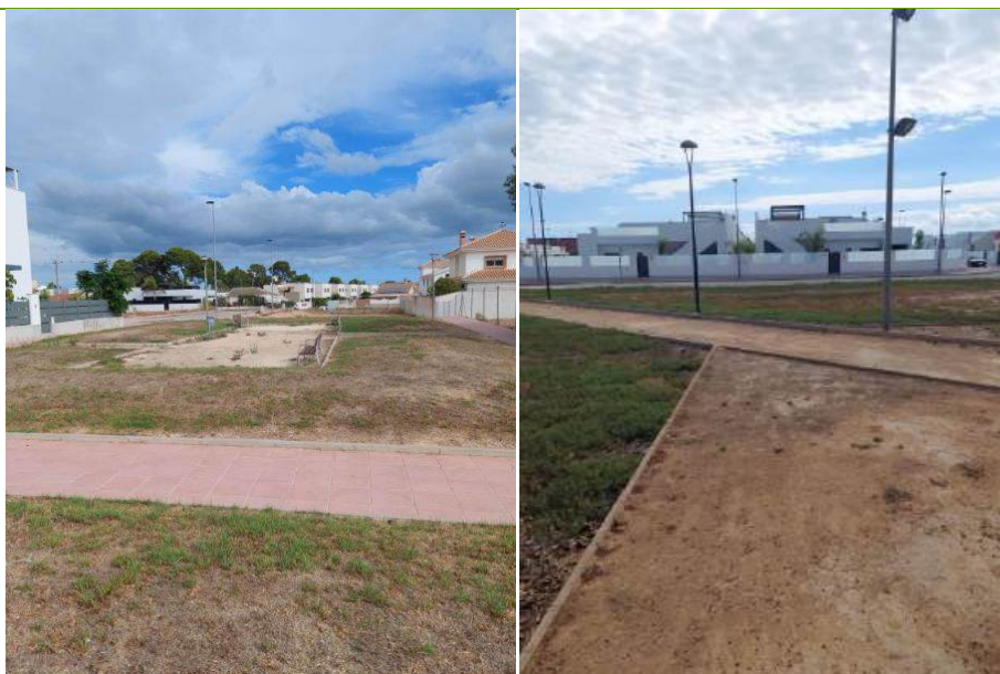
Imagen 5. Ejemplos de zonas verdes con césped en mal estado P_LR_02c1 y P_SJ_08.
