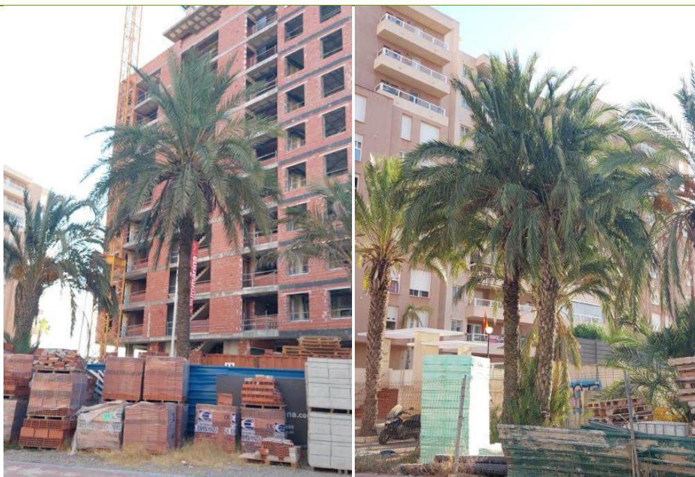
Imagen 285. Ejemplos de obras realizadas junto a arbolado, observado durante inventario (Zona Veneziola – La Manga)
