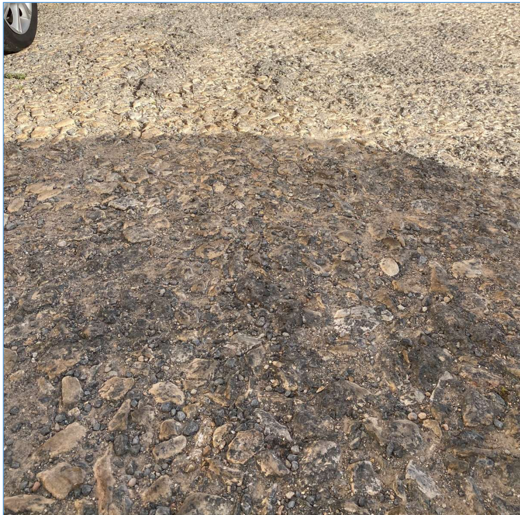
Detalle de base granular en c/ Córdoba tras desaparición del aglomerado
