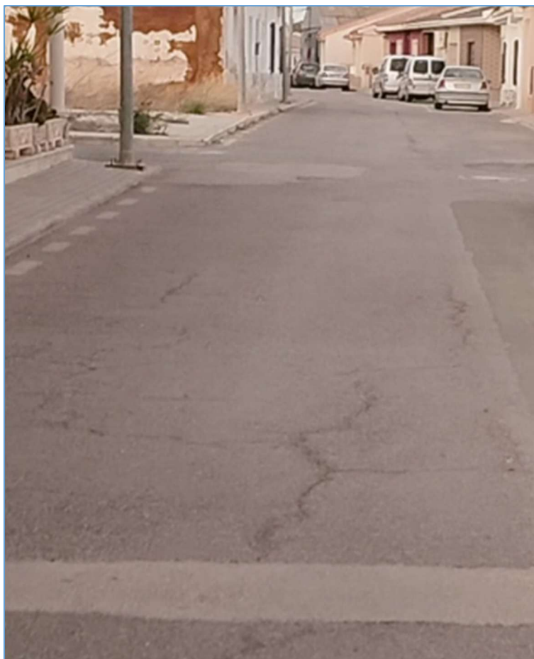
Grietas generalizadas sin deformación en c/ Laureados de España.
