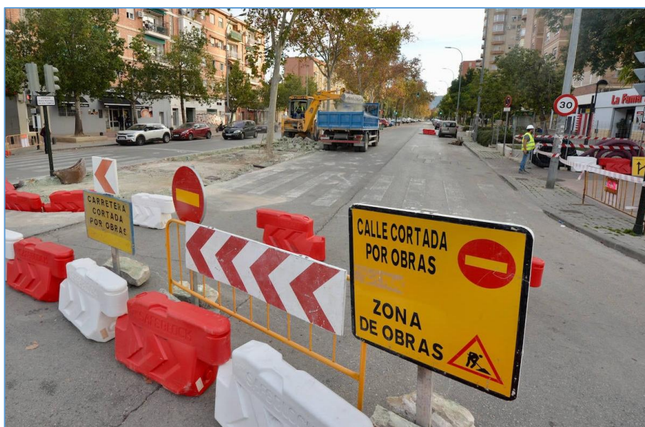
Sealizaci n y balizamiento tipo de corte de calle al tr fico
